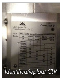
Identificatielabel ter hoogte van een aansluitpunt
